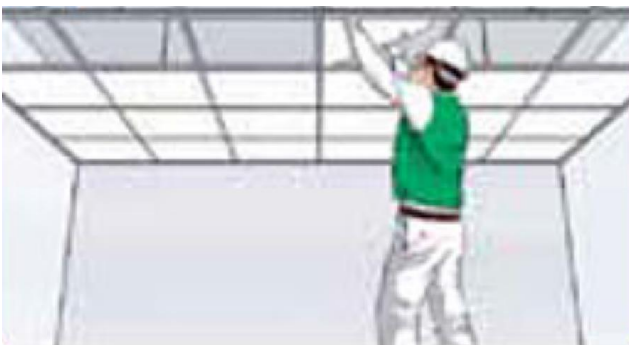
7. 방염보드 천정재 시공
