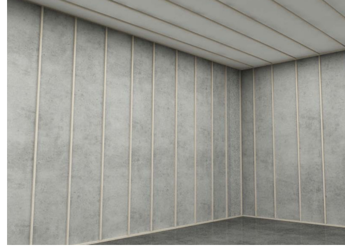
1. 내부 천정 목상 작업
