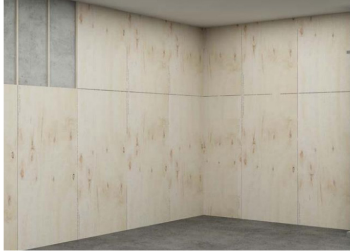
2. 9T 합판 시공
