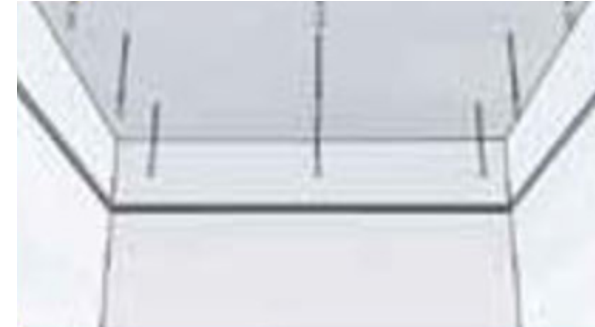
3. 행거볼트 및 행거 시공
