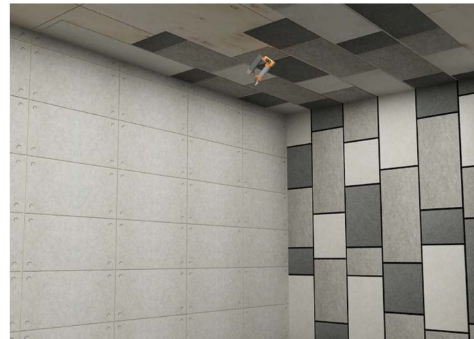
3. 시멘트보드 후면 목공 본드 작업 후 스텐신타카 시공
