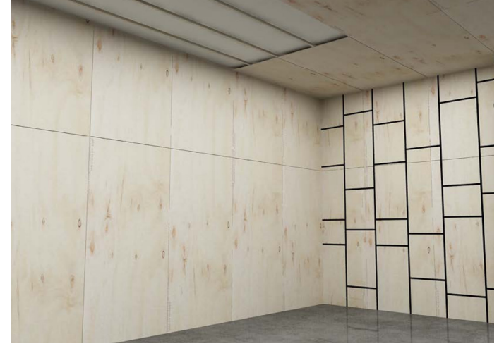
2. 9T 합판 시공
